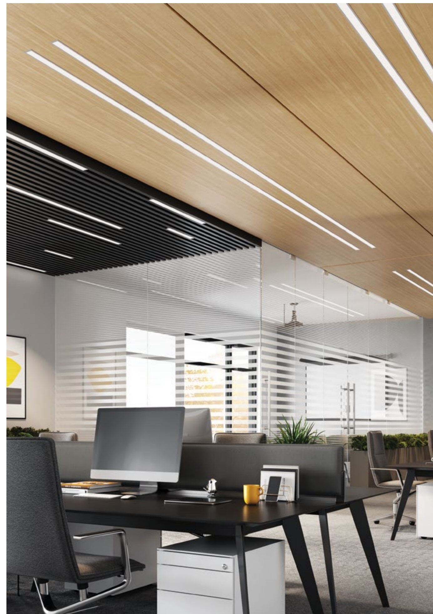
Zastosowanie podtynkowej wersji lampy Baris 52 LED w pomieszczeniu biurowym typu open space.
