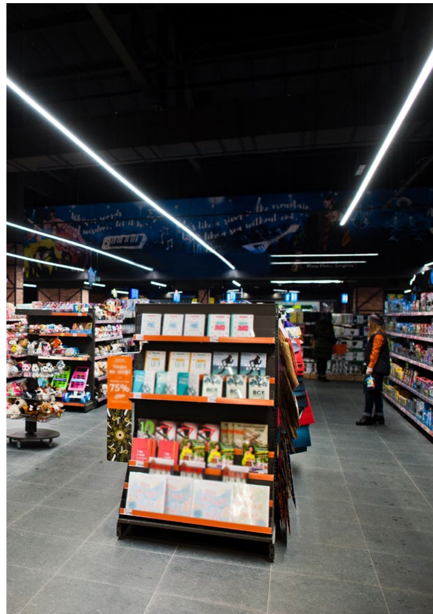
Zastosowanie linea Linea 3 LED w sklepie wielkopowierzchniowym.
